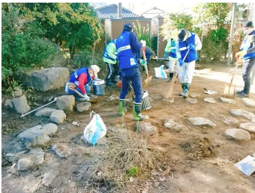
写真上：庭に堆積した泥土を掘り出す作業
