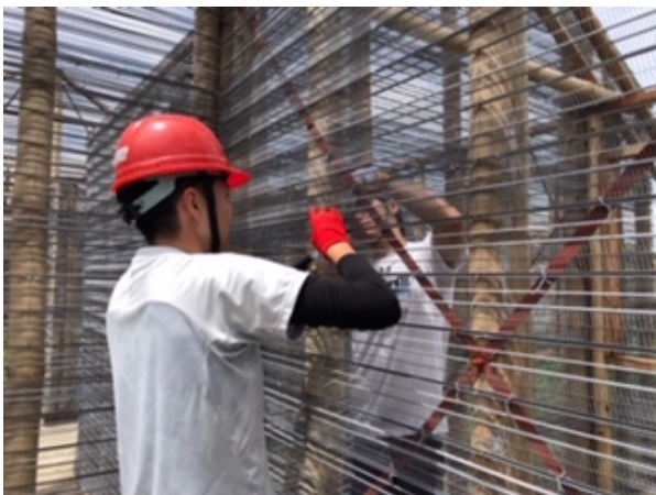
針金で金網と竹壁の連結を強化
