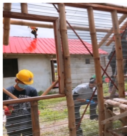
ボルトに錆止めを塗っている
