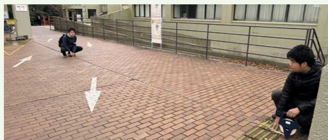
ペDESTリアンデッキの溝の調査の様子
