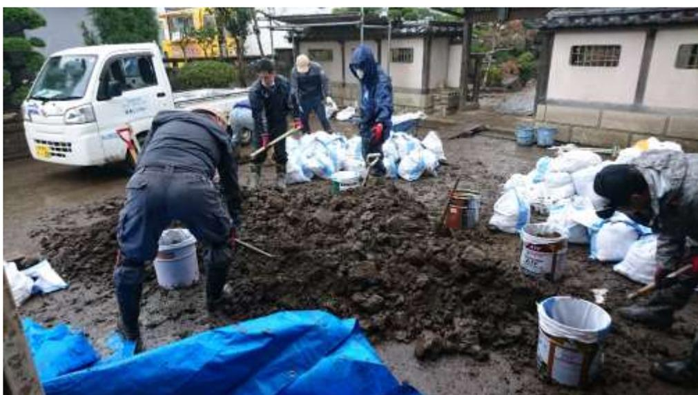
写真上：泥土を土嚢袋に詰め込む作業
