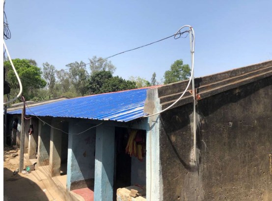
完成した屋根
