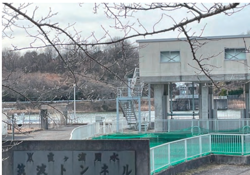
写真2 筑波トンネル
