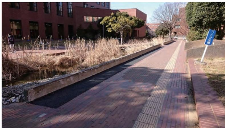
花壇を撤去し、道幅が広がったペデ（アスファルト舗装の部分が拡幅された部分）
