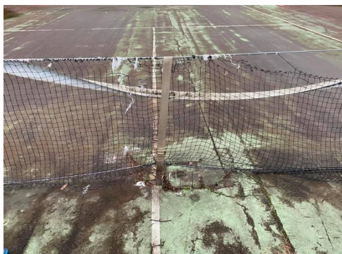
コート表面にひびが入り、ネットも破けている一の矢テニスコート (筑波大学硬式テニス愛好会 FOREST 提供)
