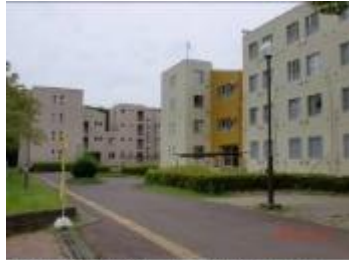
1号棟(奥)と3号棟(手前) 3号棟は改修され、新たな姿に生まれ変わった。
